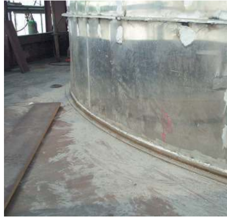
Afbeelding 14, 15 en 16 De aluminium opbouw is gelast aan het Triplate.
