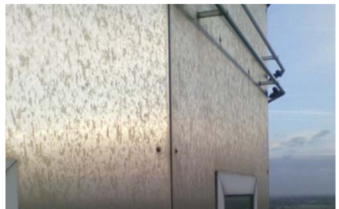
Afbeelding 2: vliegroest op gevelbekleding van roestvast staal door remmende treinstellen.
