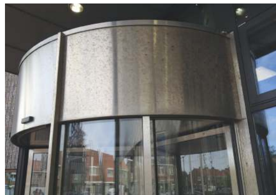
Afbeelding 5: de luifel werd nooit beregend waardoor hinderlijke corrosie extra werd gestimuleerd.
