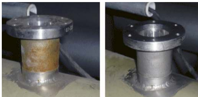
Afbeelding 8: nozzle van roestvast staal voor en na de behandeling
