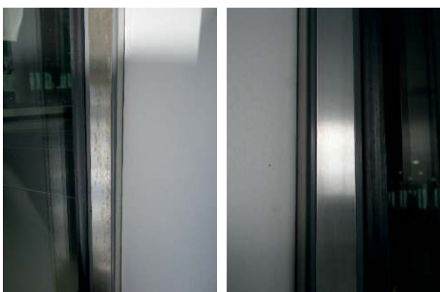
Afbeelding 7. (links) Zogenaamde theevlekken door aerosolen op een roestvaststalen 'glaslat'. Afbeelding 8. Dezelfde 'glaslat' als in afbeelding 7 maar dan behandeld.
