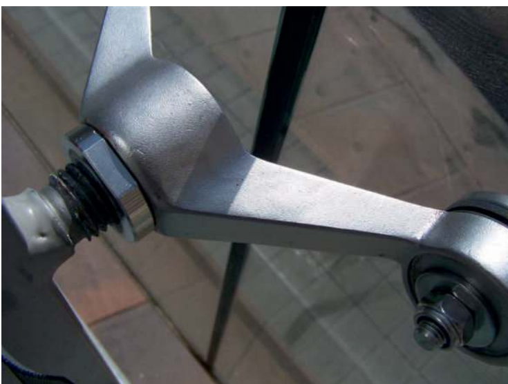
Afbeelding 4. Hetzelfde onderdeel als in afbeelding 3 echter na behandeling met Innosoft B570.
