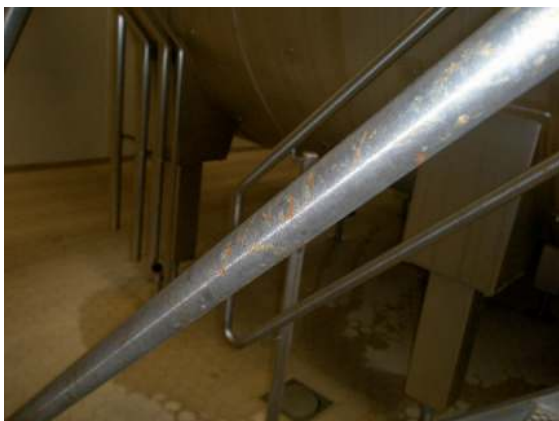
Afbeelding 5. (links) Een aangetaste leuning van RVS 304 in een kaasfabriek. Afbeelding 6. Dezelfde leuning als op afbeelding 5 maar dan behandeld met Innosoft B570.
