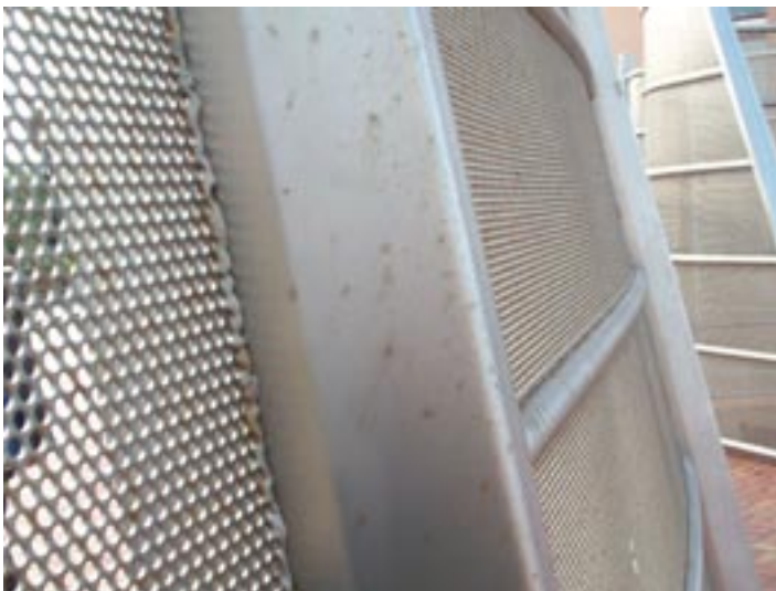
Afbeelding 4 Diverse roestputten op de pilaren van het kunstwerk.
