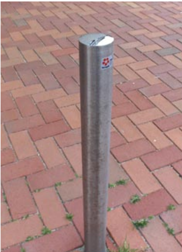
Afbeelding 1 Een RVS AISI 316 paal die gecorrodeerd is m.u.v. de gepolijste cap.
