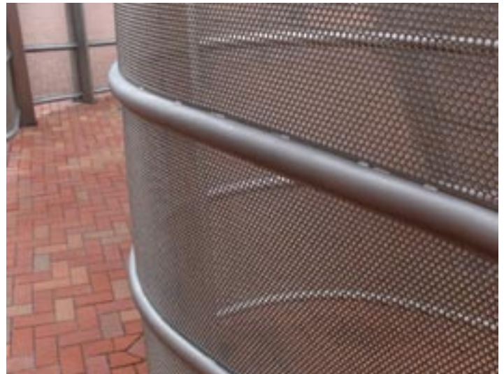
Afbeelding 6 Het windscherm na het droogijstralen.
