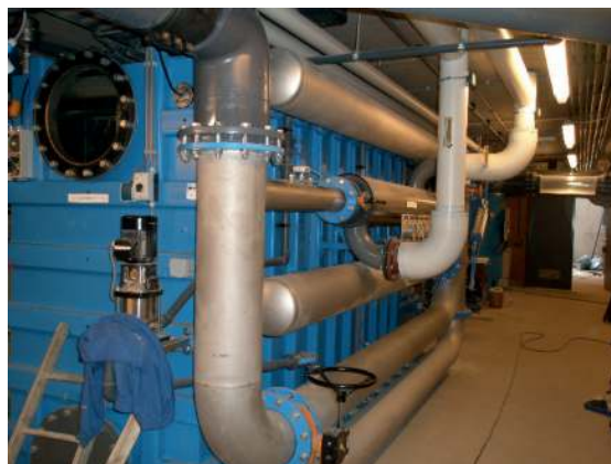
Afbeelding 3. Ook de zandbedfilters voor de reiniging van zwembadwater worden beschermd m.b.v. intelligente kathodische bescherming (foto Innomet B.V.).
