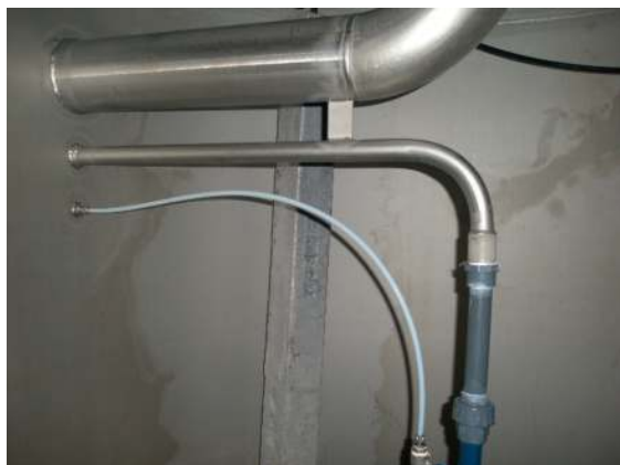
Afbeelding 2. Duidelijk is de magnesiumanode in staafvorm zichtbaar in een filterunit van een ozon reaktietank (foto Innomet B.V.).
