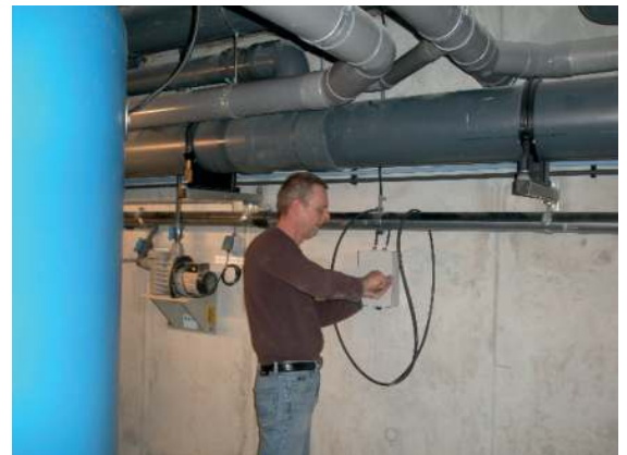
Afbeelding 1. Het aanleggen van een intelligent kathodisch beschermingssysteem in een zandbedfilter (foto Innomet B.V.).
