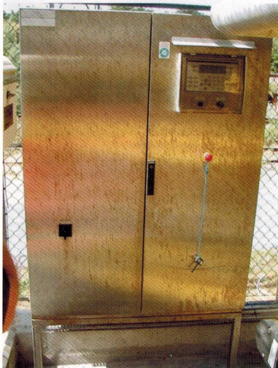
Afbeelding 8. Vliegroeest op een schakelkast van 316 vanwege aerosolen uit de zee.
