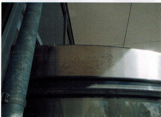
Afbeelding 3. Detail van foto 2 waarin men de aantasting door aerosolen kan zien.
