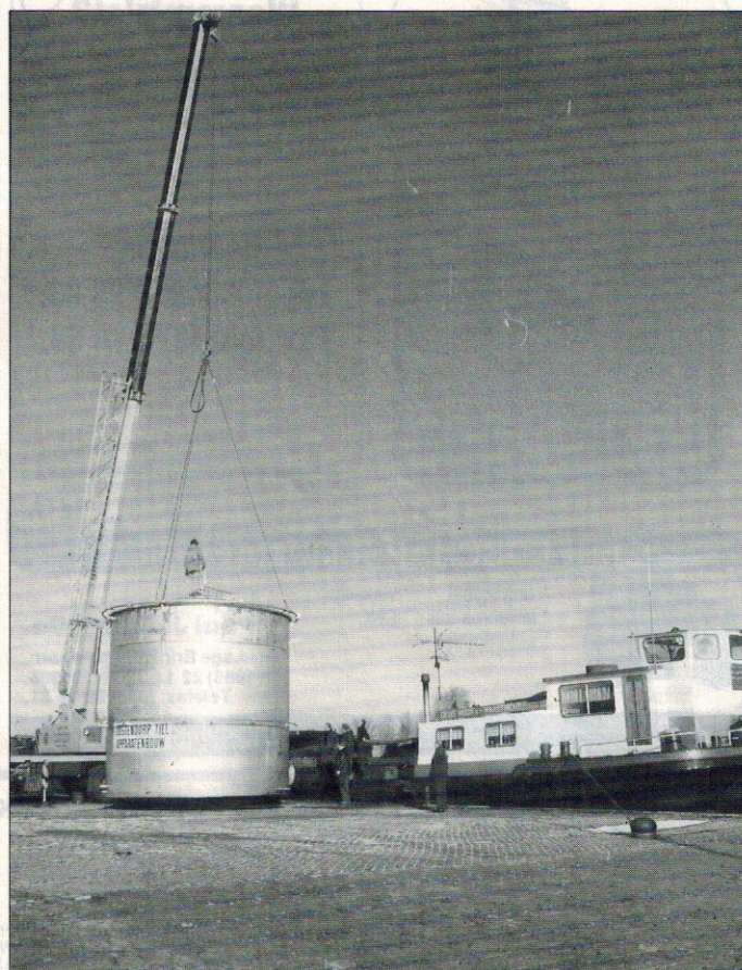
9. Deze gigantische tank is volledig van titaan vervaardigd (Oostendorp Tiel)
