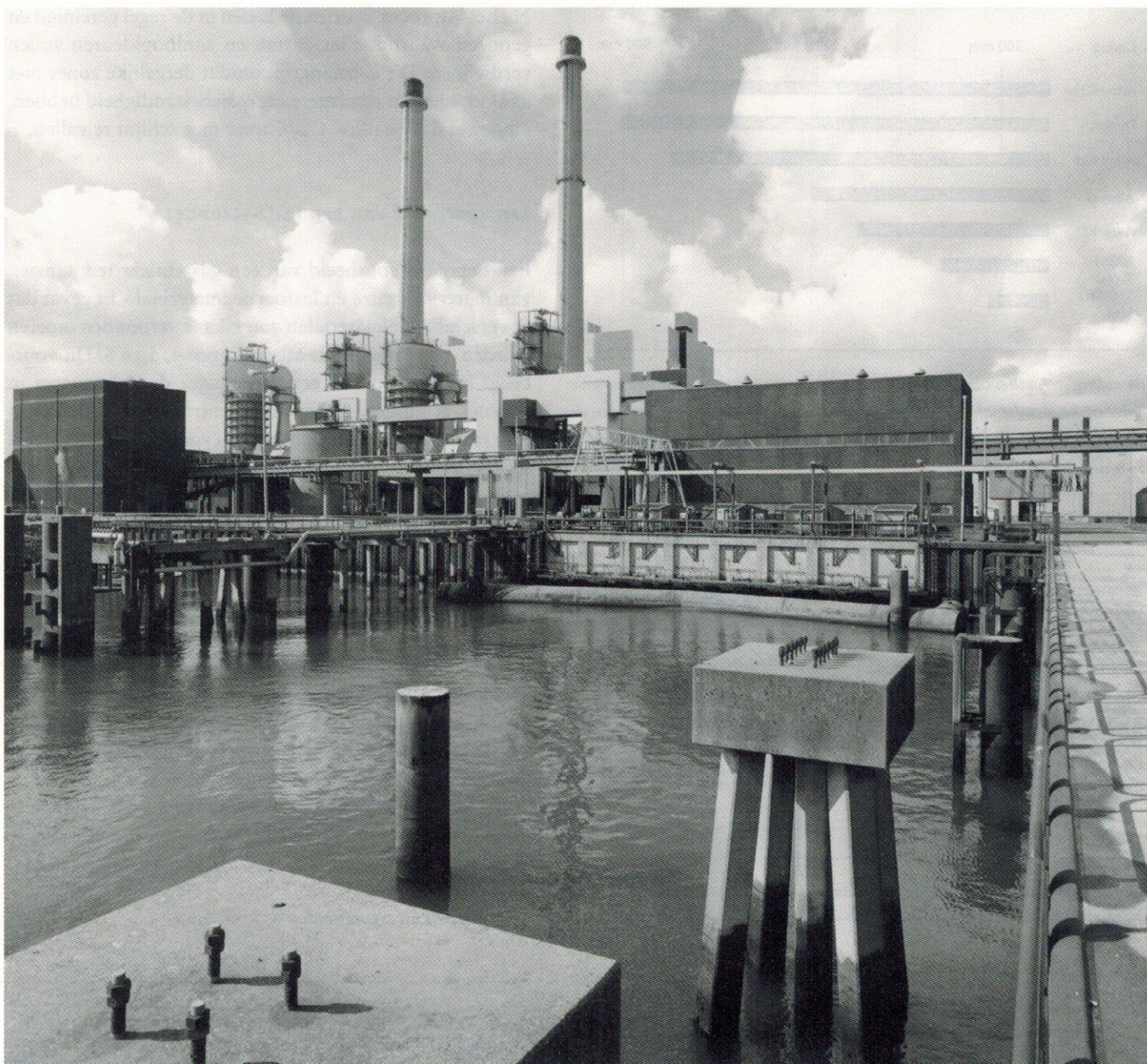
Centrale Maasvlakte van de n.v. Electriciteitsbedrijf Zuid-Holland.
