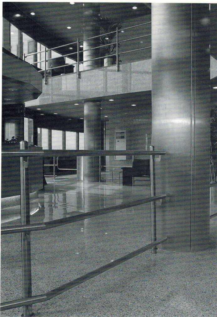
Europagebouw, Haarlem. De betonnen kolommen zijn omkleed met twee halve schalen van ongeveer 2 mm roestvast staal (AISI 304), afgewerkt met een klik-profiel. Het hek is in het werk gemaakt (foto: Dikken & Hulsinga, Leeuwarden).
