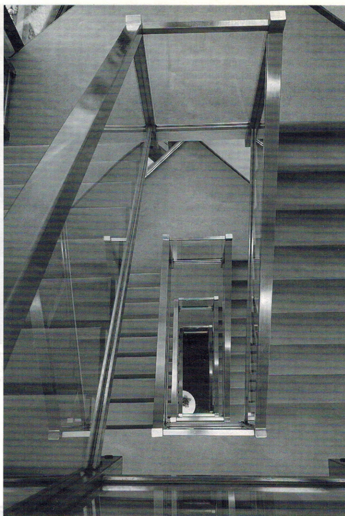
Kantoorgebouw Benelux State, Utrecht. Kokerprofielen vormen een rondgaande leuning met 8 mm gelaagd glas (foto: Dikken & Hulsinga, Leeuwarden).
