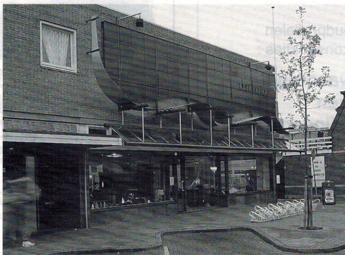
Luifel winkel Den Hartog, Alphen aan den Rijn. Voor het golvende gedeelte is gekozen voor roestvast staal (AISI 304) vanwege het 'eerlijke' en onderhoudsarme karakter.
