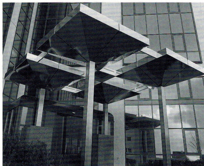
Kantoorgebouw Bergwijk Towers, Diemen. Bij de renovatie kreeg dit kantoor een entree in roestvast staal (AISI 304) in de vorm van trechters op kolommen. Het hemelwater wordt door de kolommen afgevoerd. De trechters zijn elektrolytisch gepolijst, de kolommen met korrel 320 geslepen (foto: Dikken & Hulsinga, Leeuwarden).
