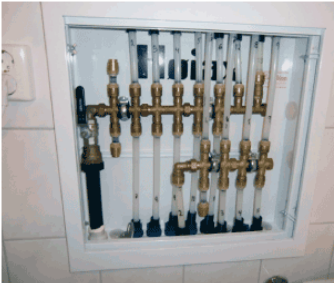
Afbeelding 3: kunststof leidingen met messing fittingen.
