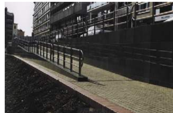
Balustrade in zeeomgeving voor blijvend nieuw uitzicht (eliminatie en voorkomen van roest- en bruinvorming).
