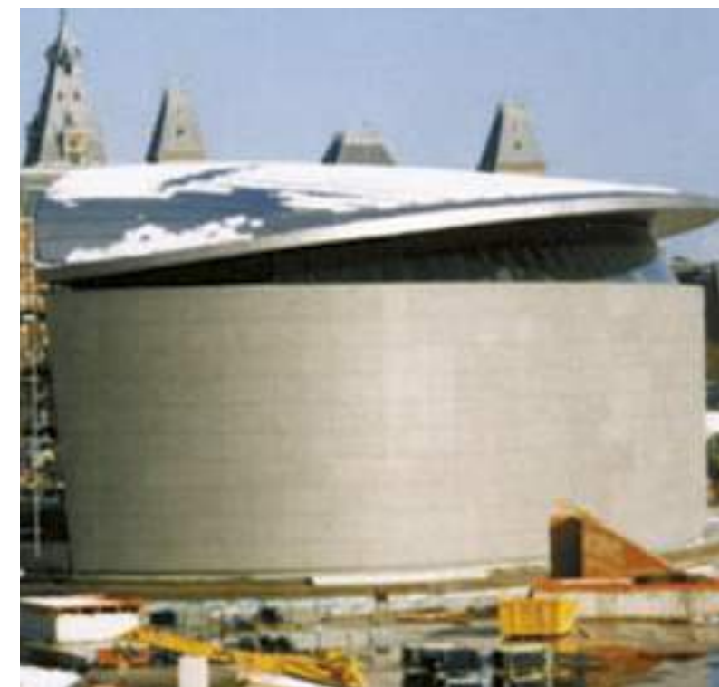
Afbeelding 1 Toepassing van titanium materiaal op dak, gevel en overstek van het Van Gogh Museum te Amsterdam. Foto: Combined Engineering B.V. te Rotterdam.
